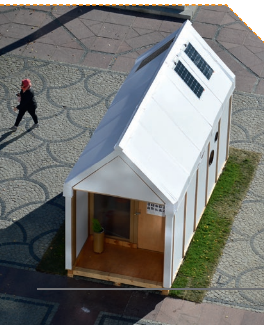
DOMEK Z KART / HOUSE OF CARDS JEST PIERWSZĄ W POLSCE JEDNOSTKĄ MIESZKALNĄ WYBUDOWANĄ W PONAD 70% Z MATERIAŁÓW POCHODZENIA PAPIEROWEGO
